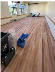
CAMBIO PISO SALAS CS. JURÍDICAS
