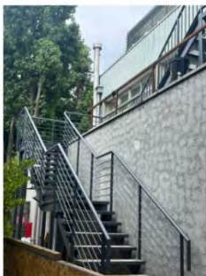
ESCALERA EMERGENCIA BIBLIOTECA LOS ÁNGELES
