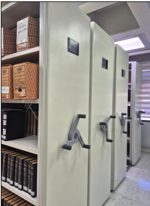
Habilitación de Depósito 2do piso Biblioteca Central Registro: Segundo semestre 2025
