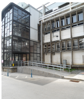
INSTALACIÓN, PROVISIÓN Y OBRAS CIVILES PARA ASCENSOR, EDIFICIO TECNOLÓGICO MECÁNICO; FACULTAD DE INGENIERÍA - CAMPUS CONCEPCIÓN
